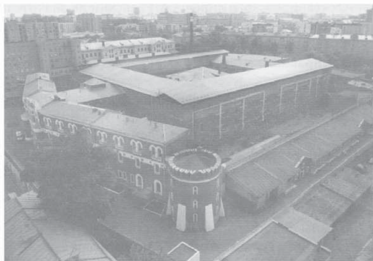
Здание Бутырской тюрьмы. Архитектор Матвей Казаков
